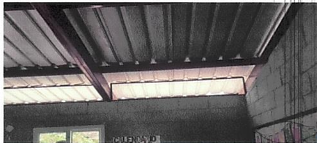
Foto 2: Instalación de marco de metal para proteger mojinete.
