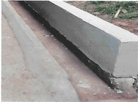
Foto 7: Restauración de cuneta de protección
