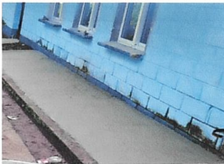
Foto 11: Nivelación de banqueta
