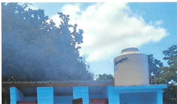
Foto 5: Instalacion de rotoplast de 1,100 litros,
