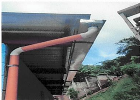
Foto1: Colocación de canales y bajadas de agua.
