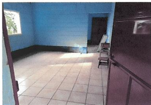
Foto 3: Mantenimiento de puertas de metal.
