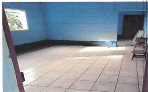
Foto 6: Pintura de interior y exterior del centro educativo.
