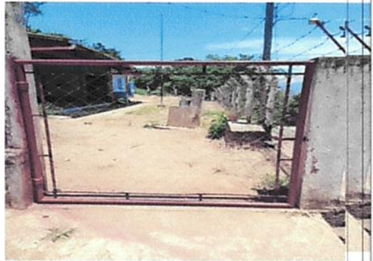
Foto 10: Reparación de portón de acceso.
